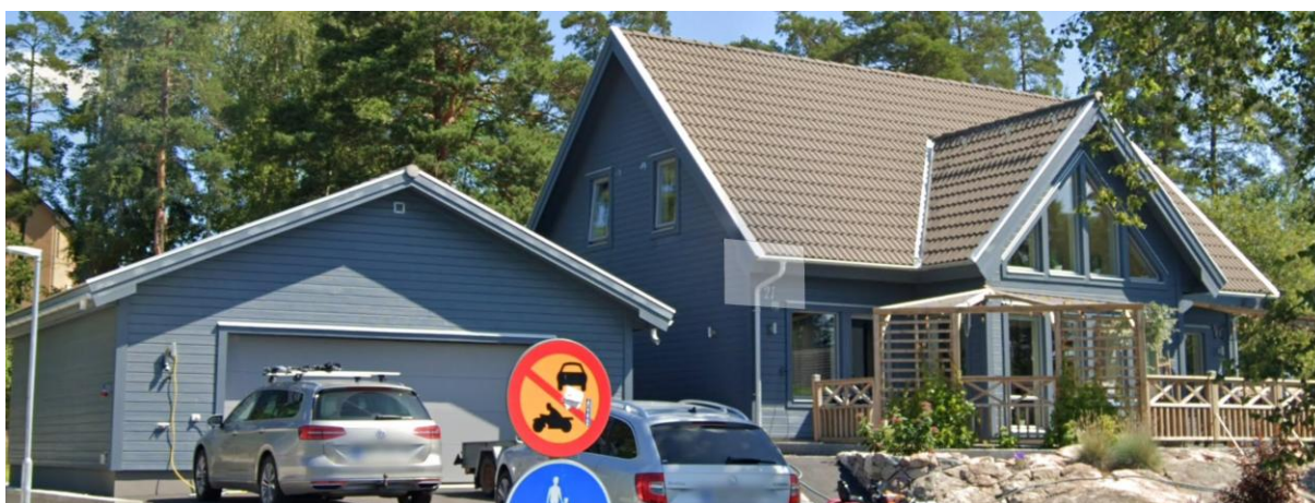
Storstensvägen 21: Ljusblå (NCS S 4305-R99B)
